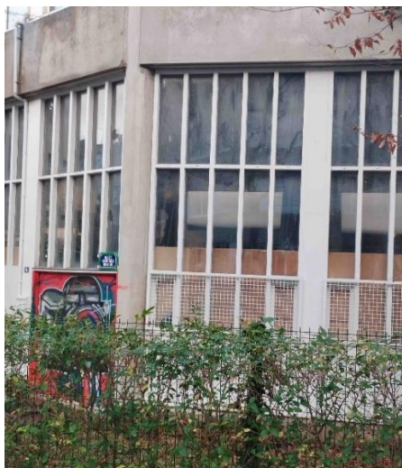
Etat actuel des façades à préserver
