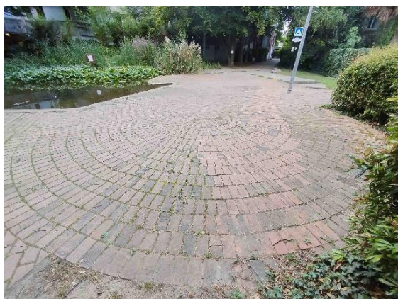
Calepinage des briques devant le Bassin
