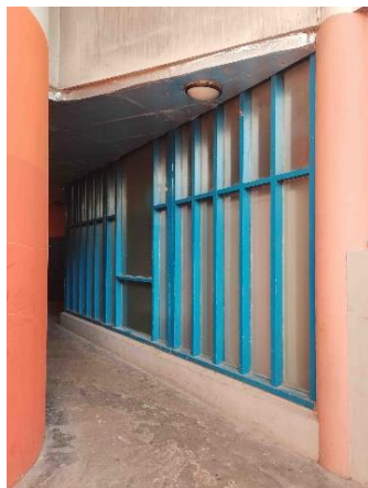
Façade vitrée du Foyer Finck donnant sur l'allée Matisse
