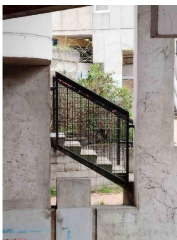
Escalier d'accès s'accrochant entre 2 voiles béton - Daquin
