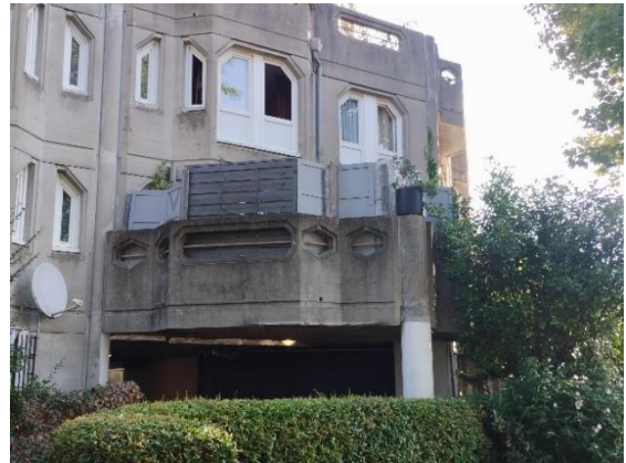
Bâches au 1er étage rue de la Maladrerie
