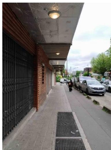
Retrait de la façade rue L. et J. Martin
