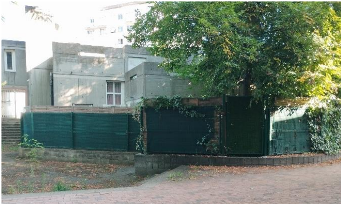
Bâches en rez-de-chaussée devant les pavillons
