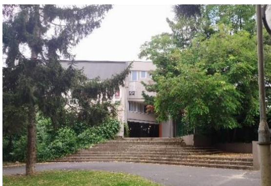
Accès à l'ilot Daquin face à l'Ecole
