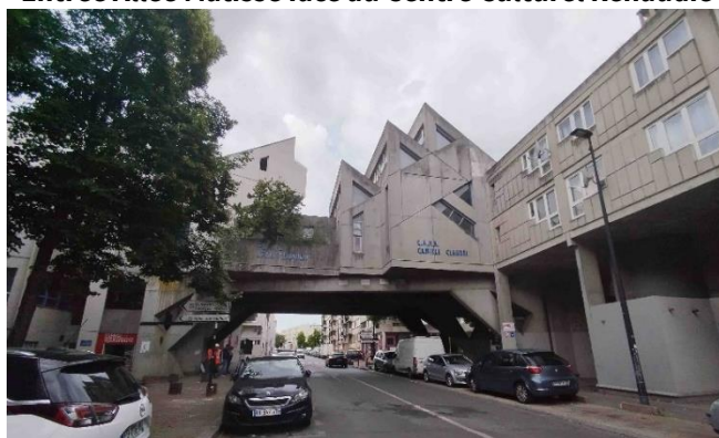
Passerelle du CAPA marquant l'entrée allée Matisse
