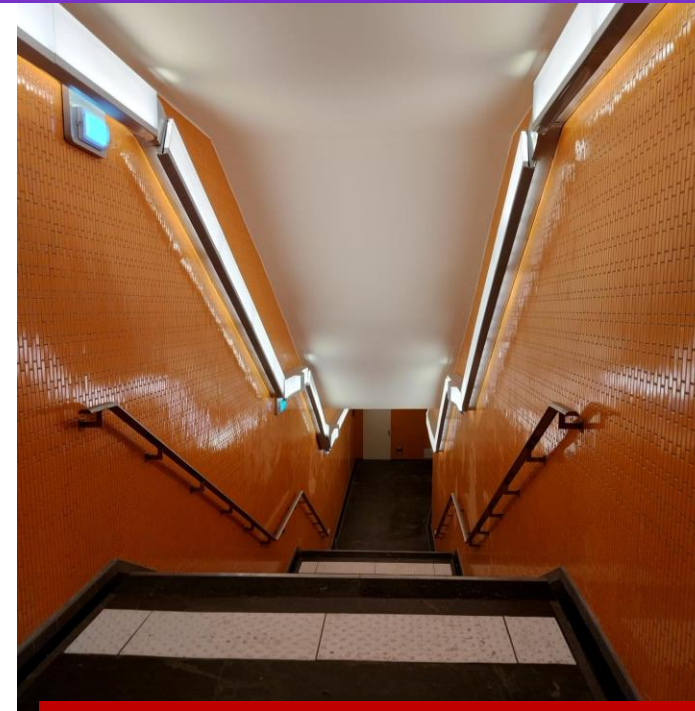
Photo 2 - Escalier sur le quai La Courneuve
