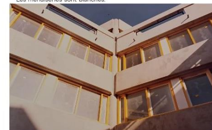
↑ Chantier de la Maladrerie, 1978, tranche 3 bât. 2 [Archives municipales d'Aubervilliers]. Les dormants sont peints en jaune.
