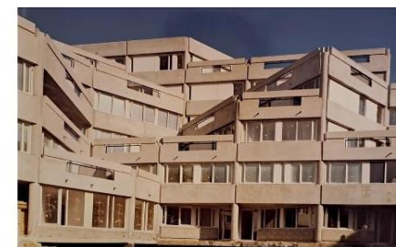
↑ Chantier de la Maladrerie, 1978 [Archives municipales d'Aubervilliers]. Les menuiseries sont blanches.
