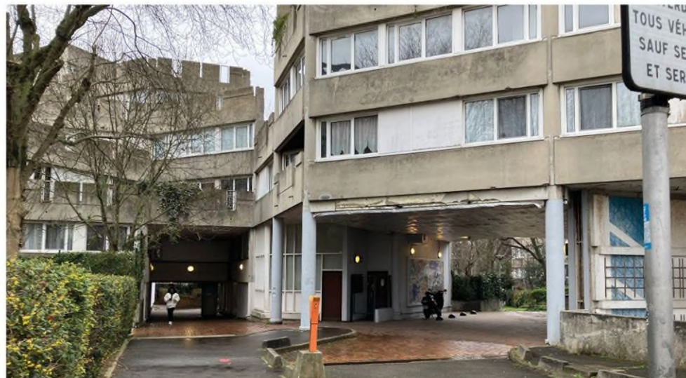
→ depuis la rue de la Maladrerie
