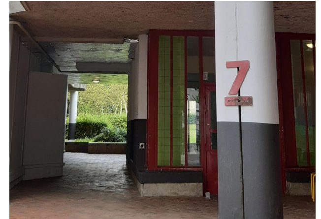
↑ exemples de signalétique (tranche 5, bâtiment 2)
