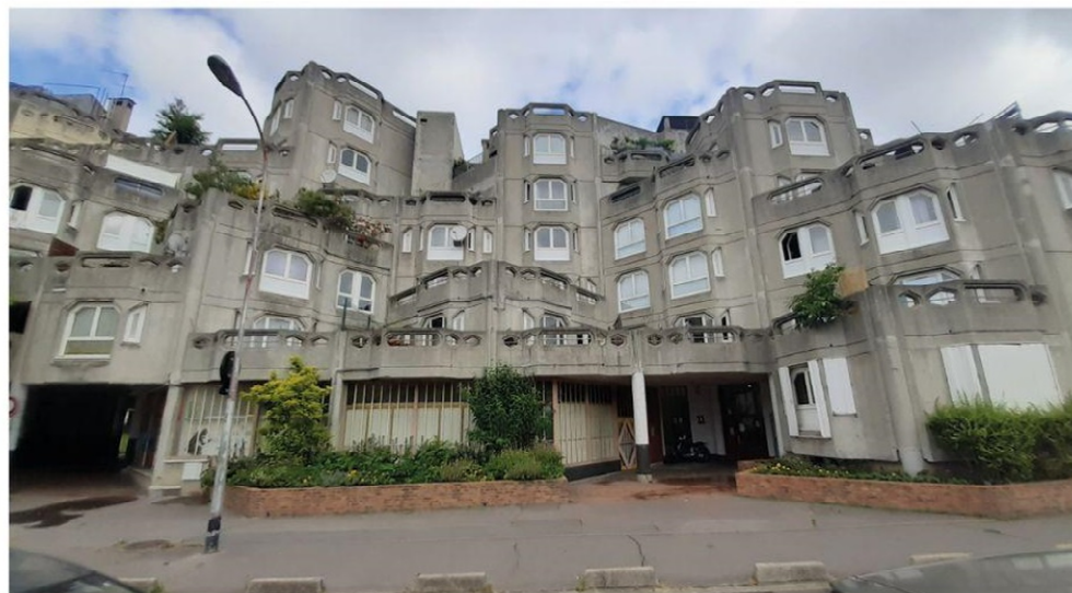
→ depuis la rue de la Maladrerie
