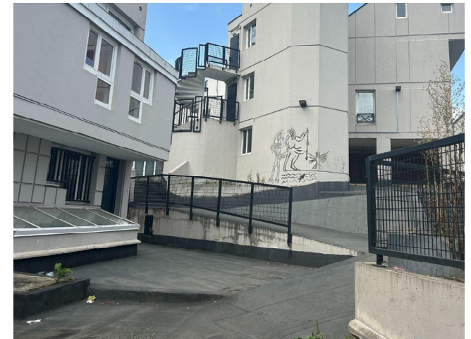
↑ espace sur dalle à revêtir tranche 7
