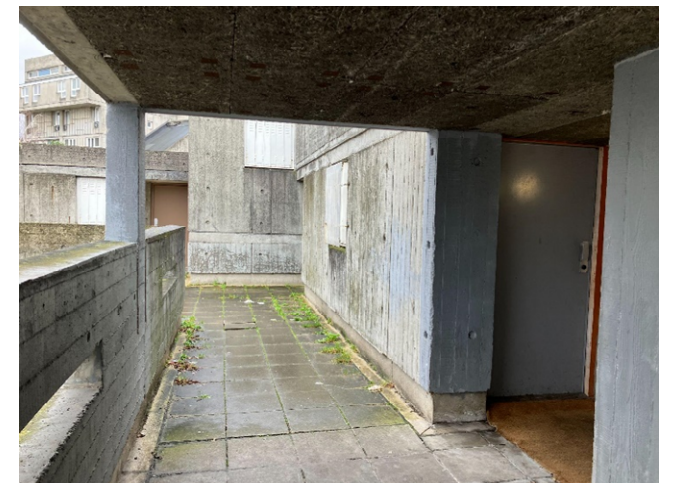
↑ coursives haute d'accès aux logement de la tranche 7bis
