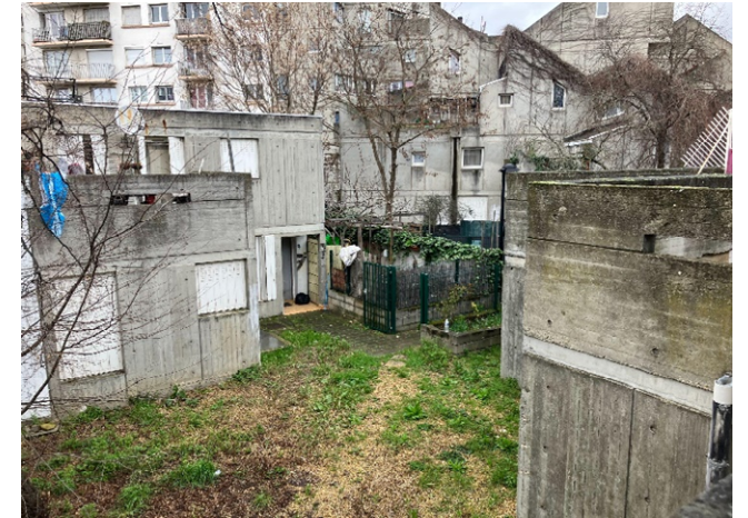
↑ espace collectif en coeur de tranche 7bis
